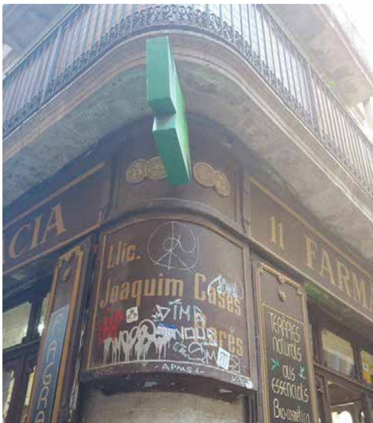
81. Detalle de la esquina de la fachada de la antigua farmacia Cases con las medallas acoladas.
