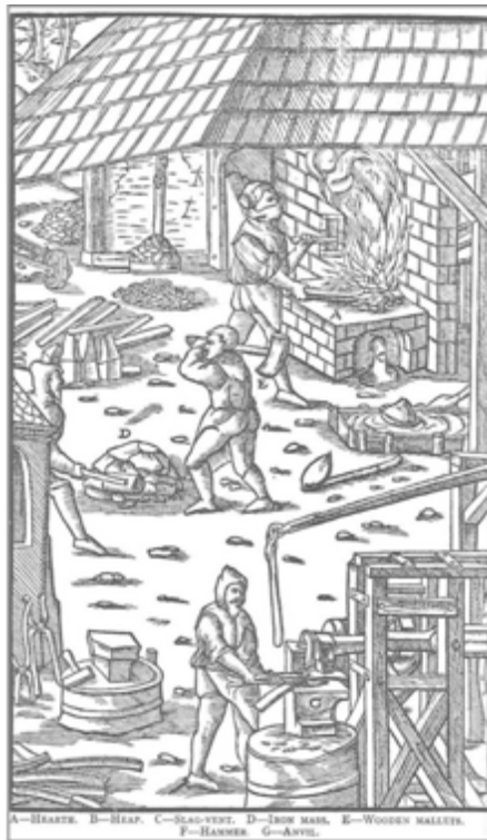
Fig 4. Grabado en madera de Instalaciones del hierro con el horno y su trabajo en el forjado. Georgius Agricola “De Re Metallica” de 1556.
