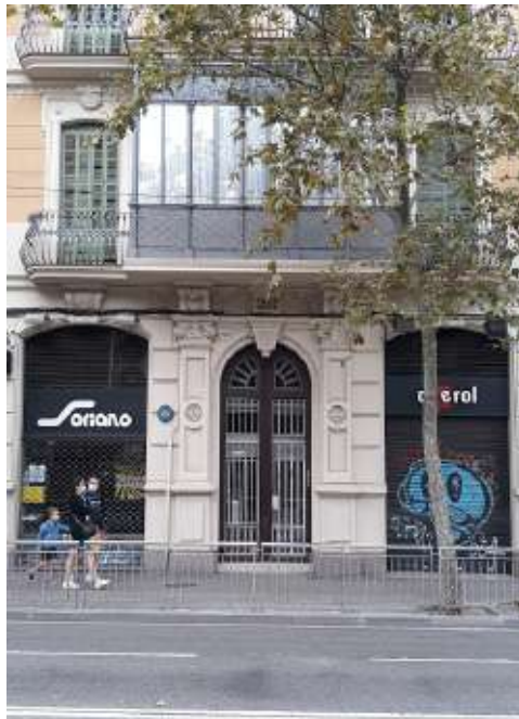
Figura 18. Calle Sants n.º 93 Barcelona(JPC)
