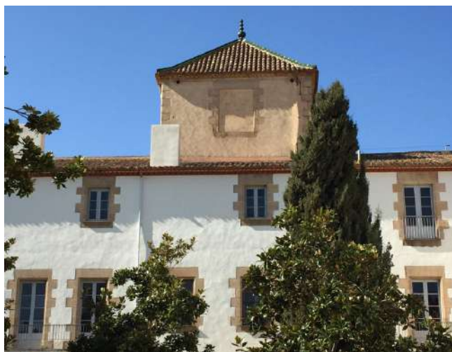
Fig.12. Torre de la entrada.
