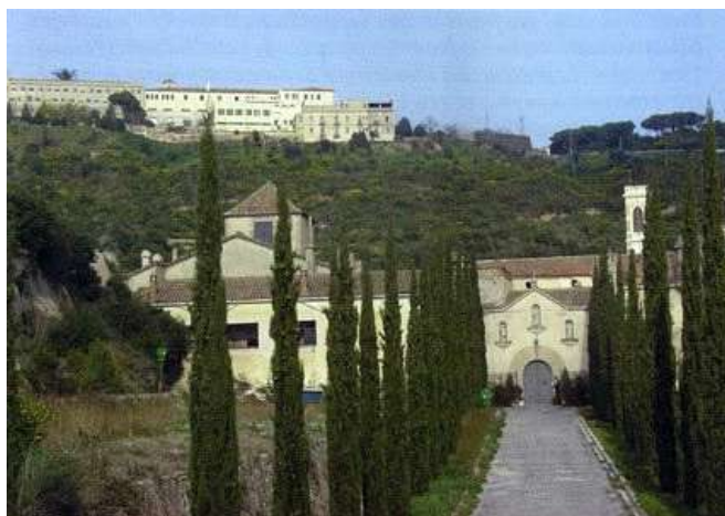
Fig. 7. Vistas de la Cartuja y de la Conrería en lo alto.
