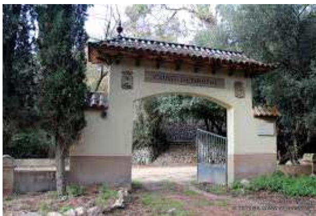
Fig. 14. Entrada de casa Senromà.
