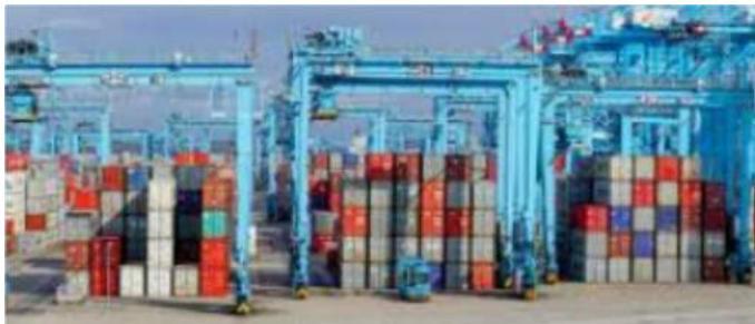
Figura 6: Terminal de Contenedores “hub” de Algeciras.
