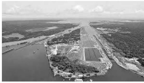
Las nuevas esclusas son más rápidas en el llenado y vaciado y consumen un 7% menos de agua; los nueve depósitos de los laterales que se emplean para la reutilización del agua permiten ahorrar hasta un 60% de este preciado bien. La ampliación del Canal permitirá a Panamá ingresar 2.500 millones de dólares al año como consecuencia de que crucen barcos más grandes. Un barco tarda en cruzar el Canal cerca de 8 horas, a diferencia los 10 días que le supondría tener que llegar hasta el Cabo de Hornos.
