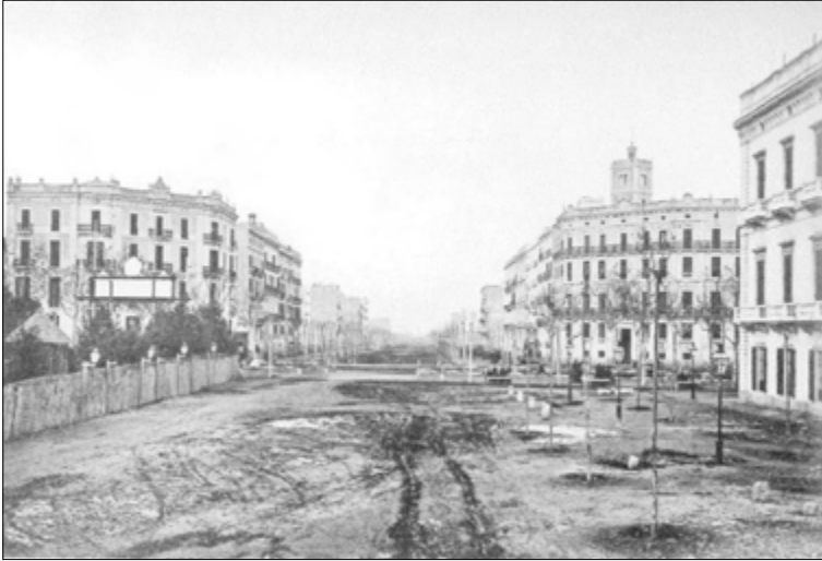
Fig.24_ Urbanización de la Gran Via de les Corts Catalanes con explanación de calle, plantación de árboles y alumbrado, 1873.
