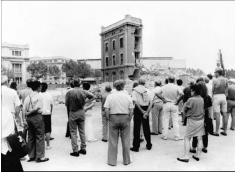
Fig. 44_ Fase final del derribo del antiguo edificio de servicios eléctricos de RENFE en la Av. Icària. Agosto 1989.
