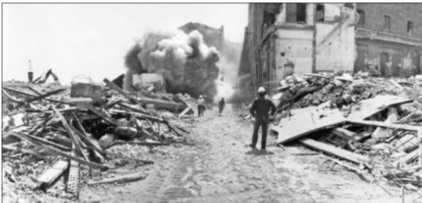
Fig. 42_ Derribo de las fábricas Folch, agosto 1987.
