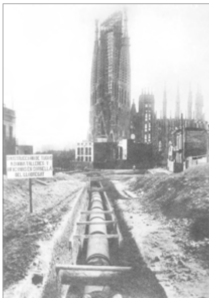
Fig.27_ Trabajos de canalizaciones en los alrededores de la Sagrada Familia, sin fecha.
