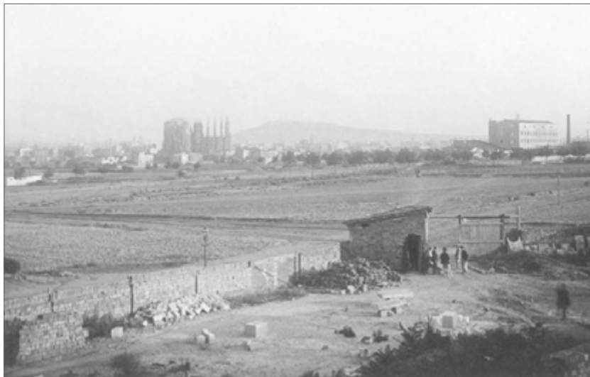
Fig.26_ Hospital de la Santa Creu y Sant Pau y la Sagrada Familia en construcción, 1902.
