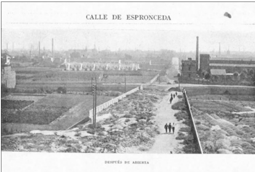
Fig.33_ Calle Espronceda después de su apertura.
