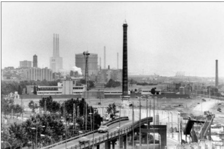
Fig. 45_ Pasarela y puente metálico sobre el ferrocarril en Av. Icària. Al fondo, la chimenea de Fábricas Folch, que aparece aislada después de los derribos, y la Depuradora de Agua Residuales del Bogatell, Junio 1988.
