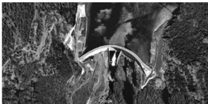
Fotografia 1.2. Vista aèria de la presa de la Llosa del Cavall (Solsona). La presa té forma de teula. Es recolza lateralment en parets de roca, tal com s'intueix a la fotografia. (Google Images; https://www.geocaching.com/geocache/GC21CA7_presa-de-la-llosa-del-cavall?guid=2f9f6df0-32df-4955-ad00-33c460da98a3 ).
