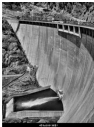
Fotografia 1.3. Presa de la Llosa del Cavall (Solsona). Alçat del parament aigües avall, amb vistes de l'abocador a la cota màxima i del conc esmorteïdor al peu
