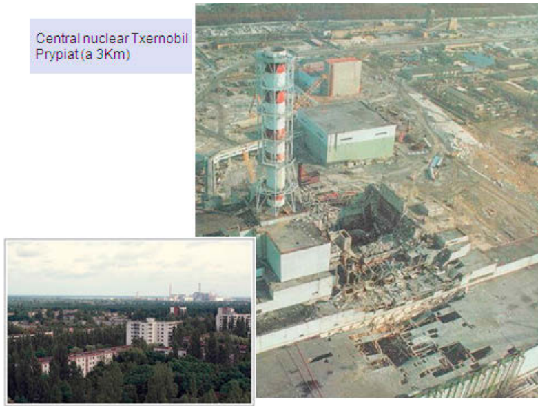
Fig. 1. A la izquierda, vista de la población de Prypiat, situada a 3Km. De la central antes de su evacuación a causa del accidente. A la derecha, imagen de la central después del accidente, con los daños estructurales causados por la explosión, que volatilizó el techo del edificio en que estaba el reactor.
