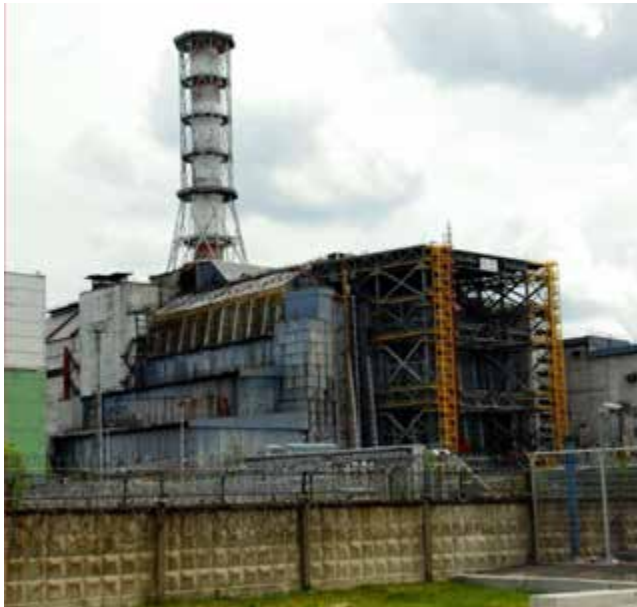
Fig.3 Blindaje de contención realizado por los “liquidadores”, popularmente conocido como “sarcófago”. Actualmente se está construyendo un nuevo debido a las fugas y fallos estructurales detectados.
